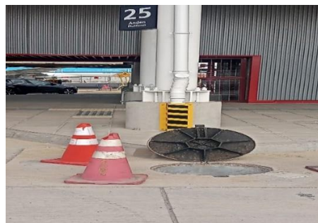
Imagen n°2 / Pruebas de canaletas CTR cubierta.
