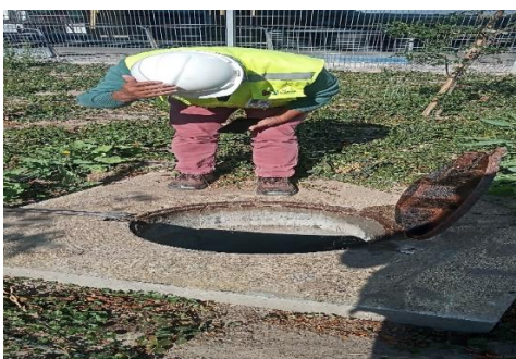
Imagen n°3 / Control de alcantarillado funcionamiento de banqueta.
