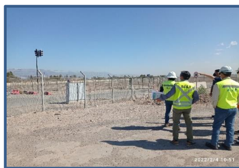
Imagen n°6 / visita al perímetro para verificación de estado del terreno.
